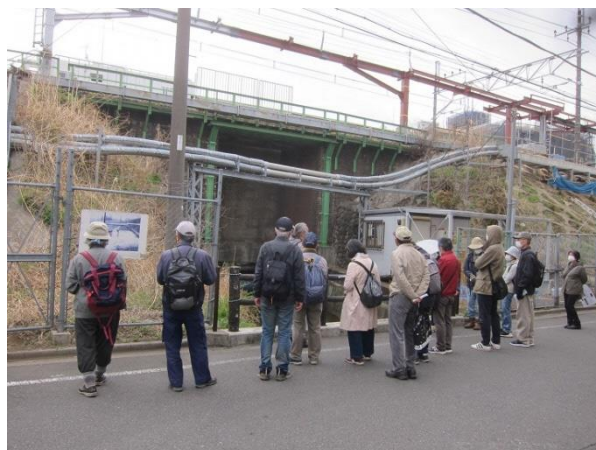
日野煉瓦橋梁 延伸工事が進むホーム(後方)
